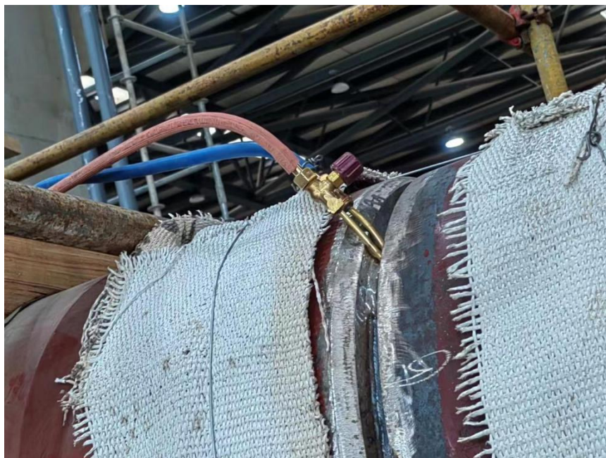
图 7 事故现场往管道输入氦气的氦气管
